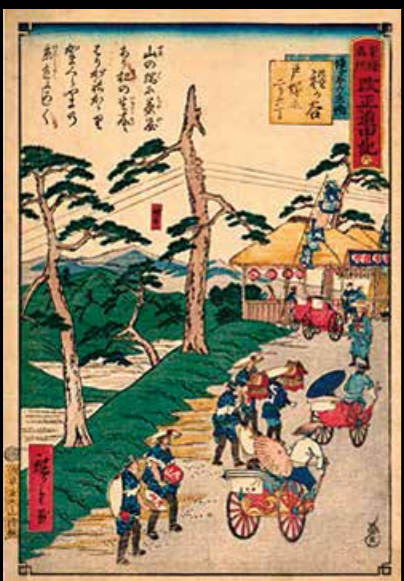
▲明治初期の浮世絵(三代目・広重「東海名所改正道中記・程ヶ谷」)には、並木の松に直接電信線を取り付けてある様子が描かれており、その突貫工事ぶりがうかがえる。
